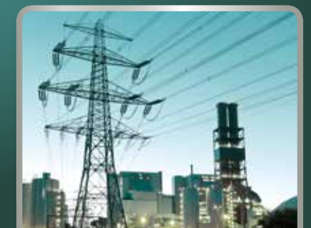
Budowa i konserwacja elektrowni
